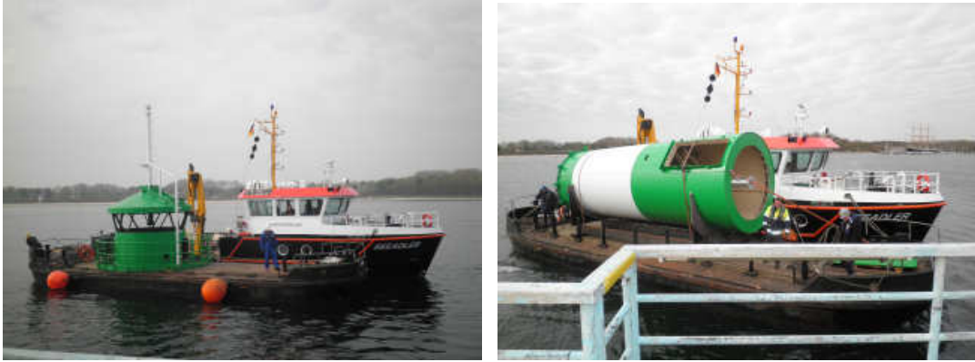
Abb. 3 und 4: Wassertransport des Laternengeschosses und des Turmschaftes zur Mole
