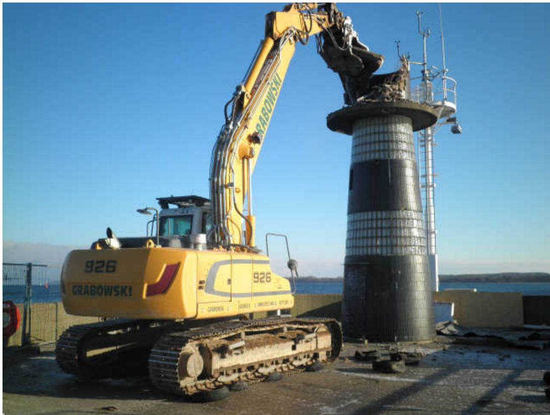
Abb. 2: Abbruch der alten Nordermolenbake im Dezember 2012
