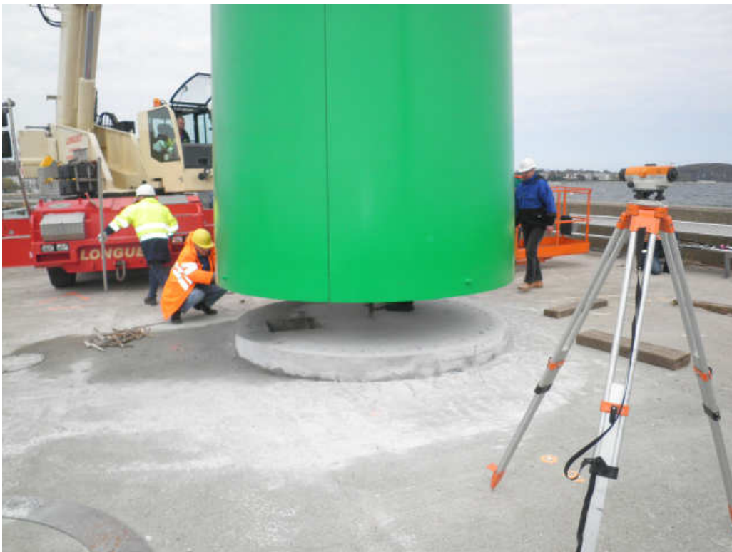
Abb. 5: Aufsetzen des Turmschaftes auf den Stahlbetonsockel
